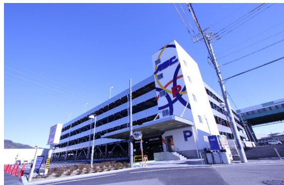
A B C 静岡中吉田店 立体駐車場
